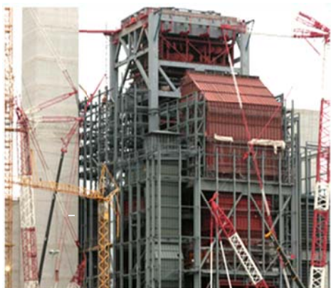
Neubau Kraftwerk - Moorburg
