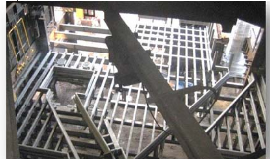
HO 3 Neuzustellung für Arcelor Mittal Bremen
